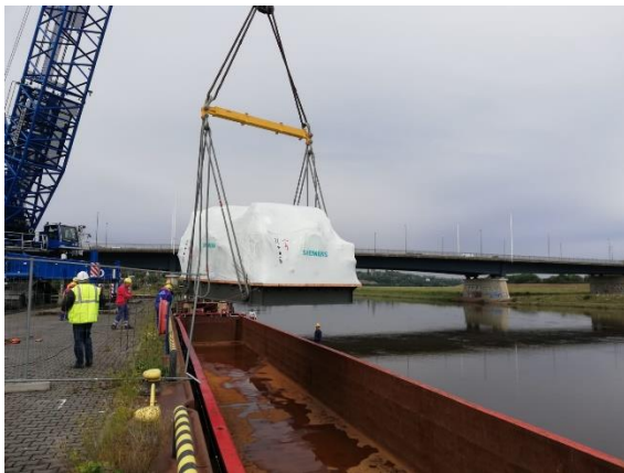
Verladung einer 167-Tonnen-Turbine im Alberthafen Dresden (Foto: SBO)
